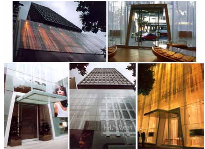
Figura 15: Sede da H.Stern no Rio de Janeiro Fonte: H.Stern
